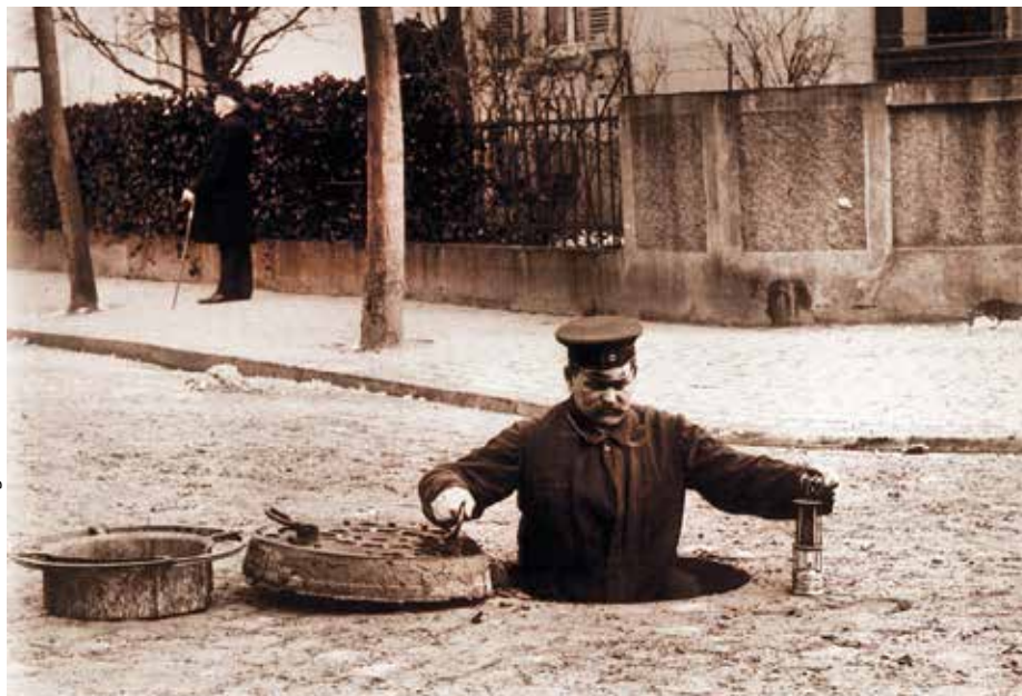
Foto: Stadtentwässerung Frankfurt
