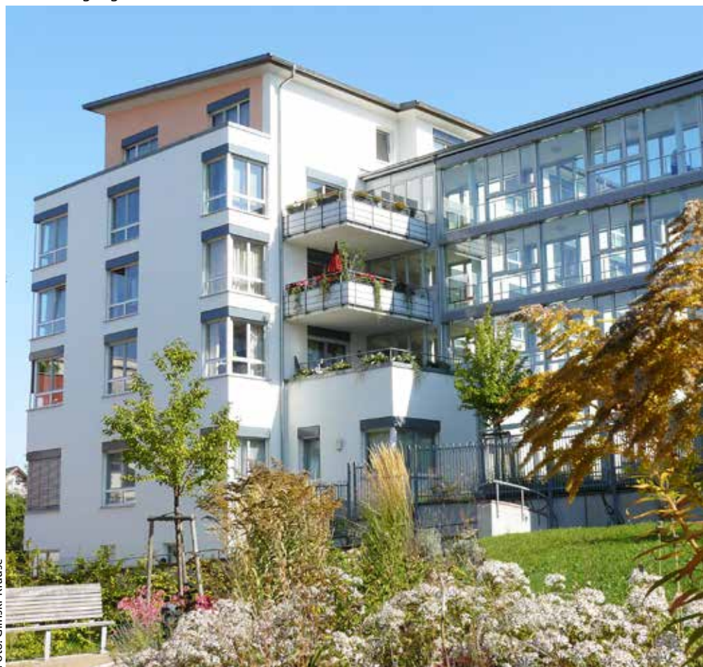
Das Versorgungshaus und Wiesenhüttenstift heute.
