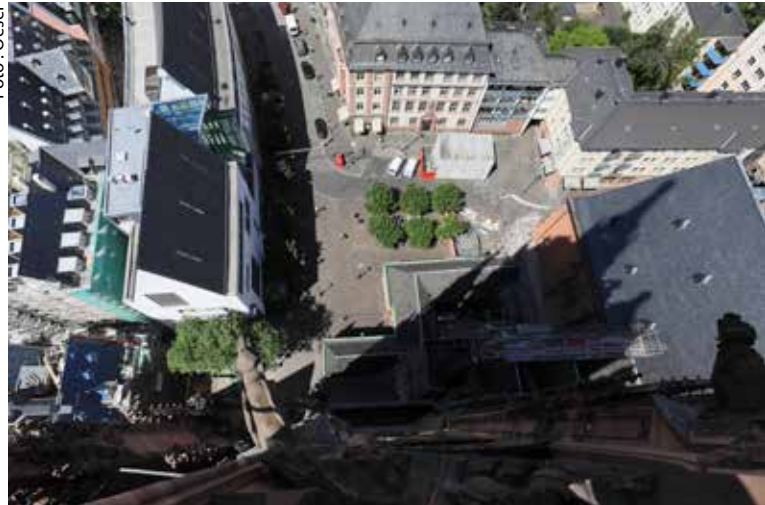
Domplatz Nordseite vom Domturm aus gesehen
