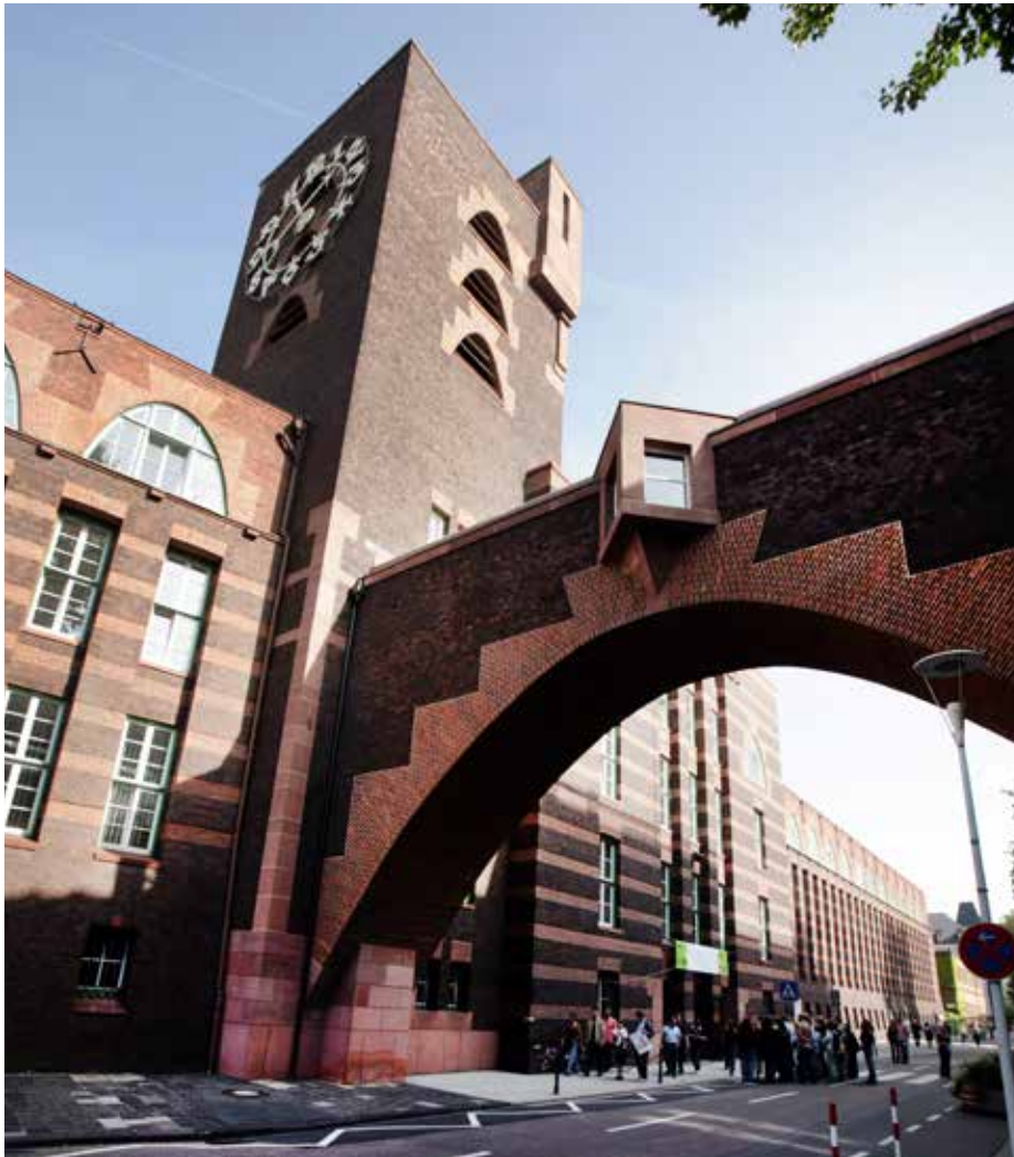
Brücke und Turm wurden zum Firmensignet der Hoechst AG.
