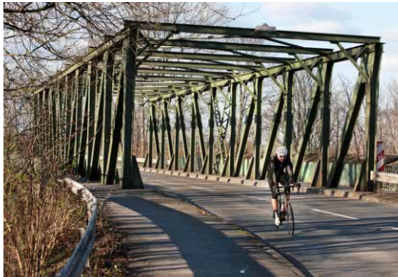
Brücke über die Eisenbahnschienen in der Homburger Landstraße
